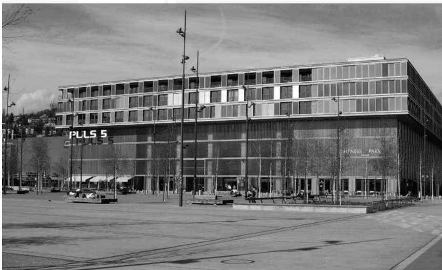
Fig. 1 – Le projet Puls 5 à Zürich West comprend des activités économiques sur quatre niveaux et une centaine de nouveaux « lofts » aux trois derniers étages (source : Rérat, 2007)
